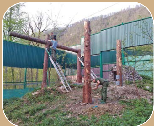
Обустройство деревянной 3D конструкции
