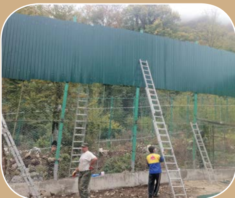
Ремонт и модернизация ограждения вольер
